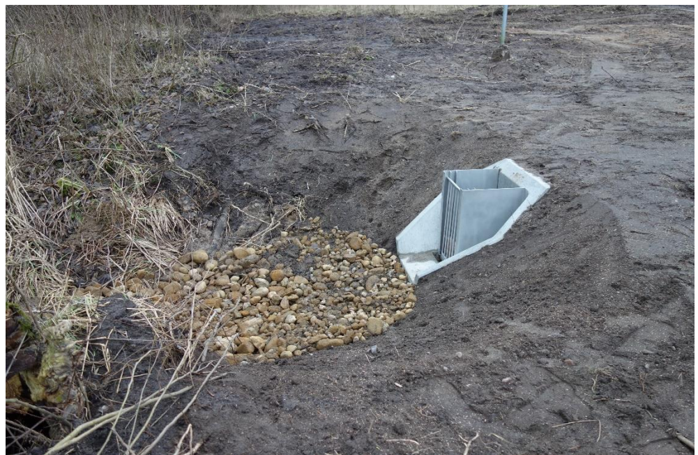
Erfolgte Maßnahmen: Erneuerung von Rohrleitungen und deren Anschluss an Graben sowie Neubau eines Rohrdurchlasses mit definierter Sohlhöhe.
