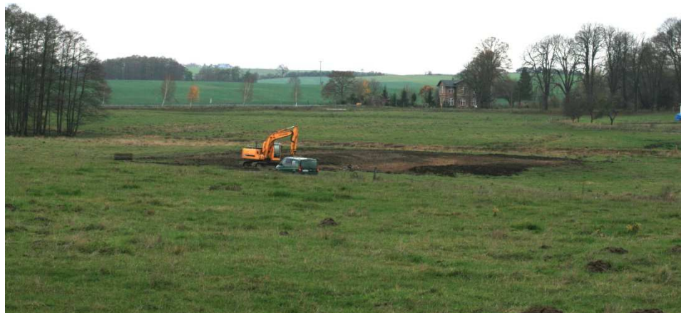
Foto 3: Abschluss der Rückbaumaßnahme (Stand 11/2015)
